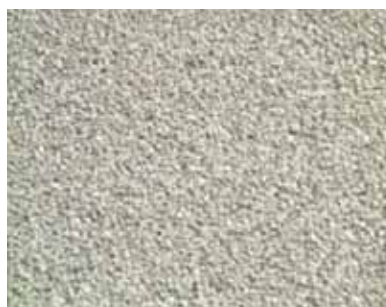
施工後の舗装表面
