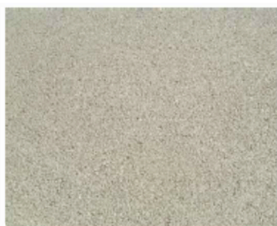
施工後の舗装表面
