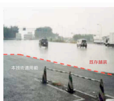
施工後の状況
